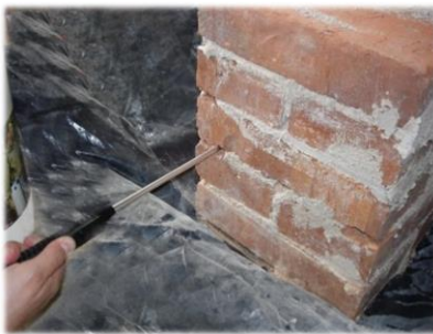
Aplikace pomocí nízkotlakového postřikovače (pumpy)
